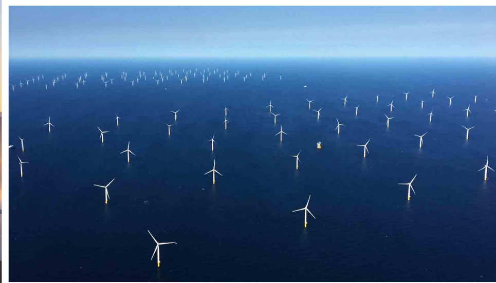
Parco eolico offshore
